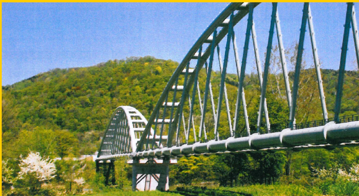
【神竜水管橋遠景】
