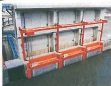
神電頭首工の取水口に設置されたディスクスクリーン
